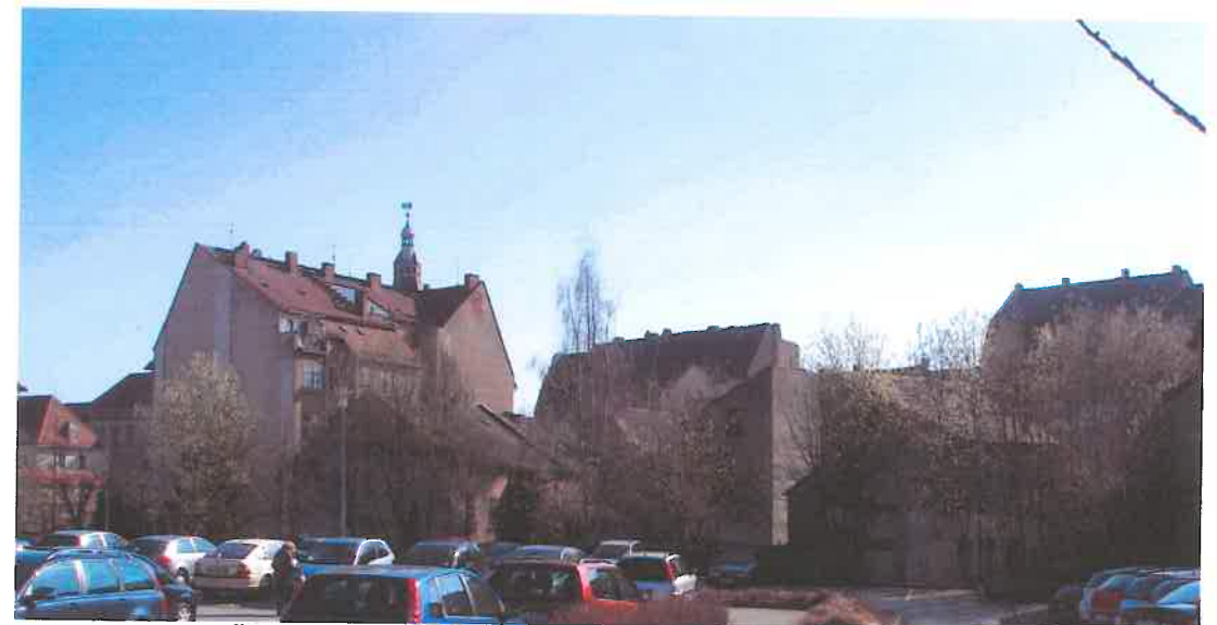
Überbauung der Grundstücke und Promenadenring 16 (Hinteransicht)
