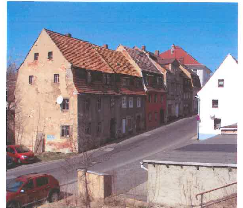
Nr. 16 bis Nr. 4 „Seniorenwohnanlage An der Seltenrein“ (Straßenansicht)
