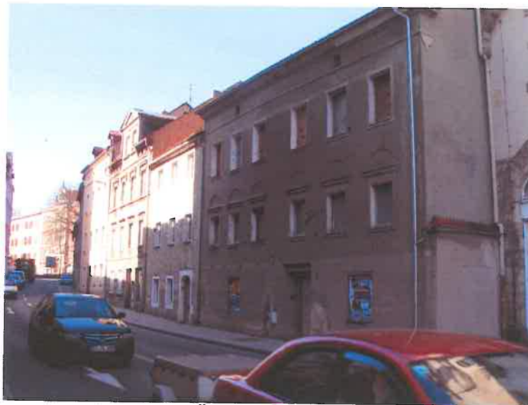
nördliche Bebauung Äußere Bautzener Straße (Straßenansicht)
