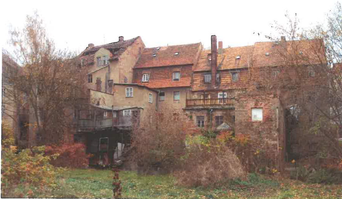
Äußere Zittauer 6 bis 16 (Hinteransicht)
