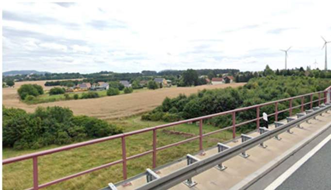
Blick von der neu trassierten B 178 n auf Carlsbrunn mit der Wohnbebauung Wohlaer Str. 12, links
