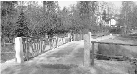
Die neue Brücke wurde auf die alten Fundamente (alten Widerlager) aufgelegt, welche für die neue Brückenplatte vorbereitet wurden. Nur der obere Bereich musste som... erneuert werden. Die Platte ist aus einem Stück gefertigt.
