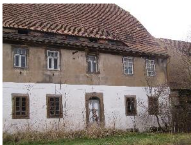
das unter Denkmalschutz stehende ehemalige Rittergut
