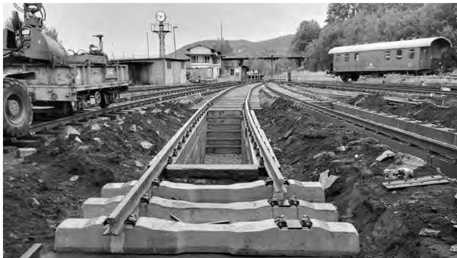
Mit der Investition in die Erneuerung der Zufahrten zum Maschinenhaus ist ein großer Schritt zur Modernisierung unserer Anschlussbahn geschafft. (Foto: Maximilian Schöne)
