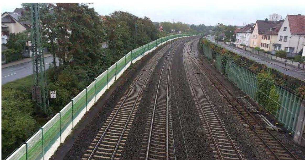
Foto: Beispiel für Lärmschutz entlang einer Haupteisenbahnstrecke
